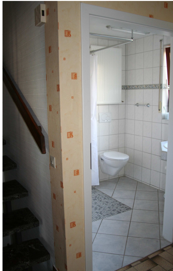
Umbau einer Gästetoilette zum barrierefreien Bad.
